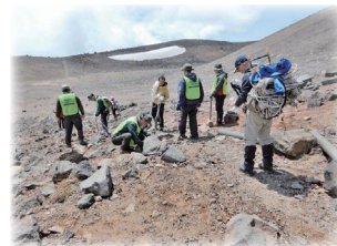
(写真33) ロープ交換作業
